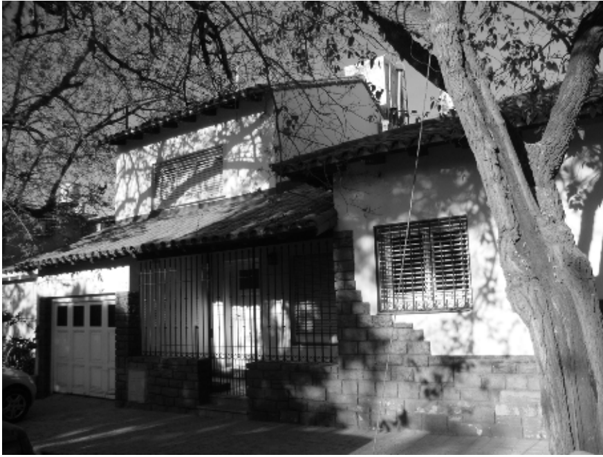
Nombre de la obra: Casa-estudio del arquitecto Ubicación: Alpatocal 1241, Mendoza. Comitente: Sergio Moglia Fuente/ fotógrafo: Isabel Durá
