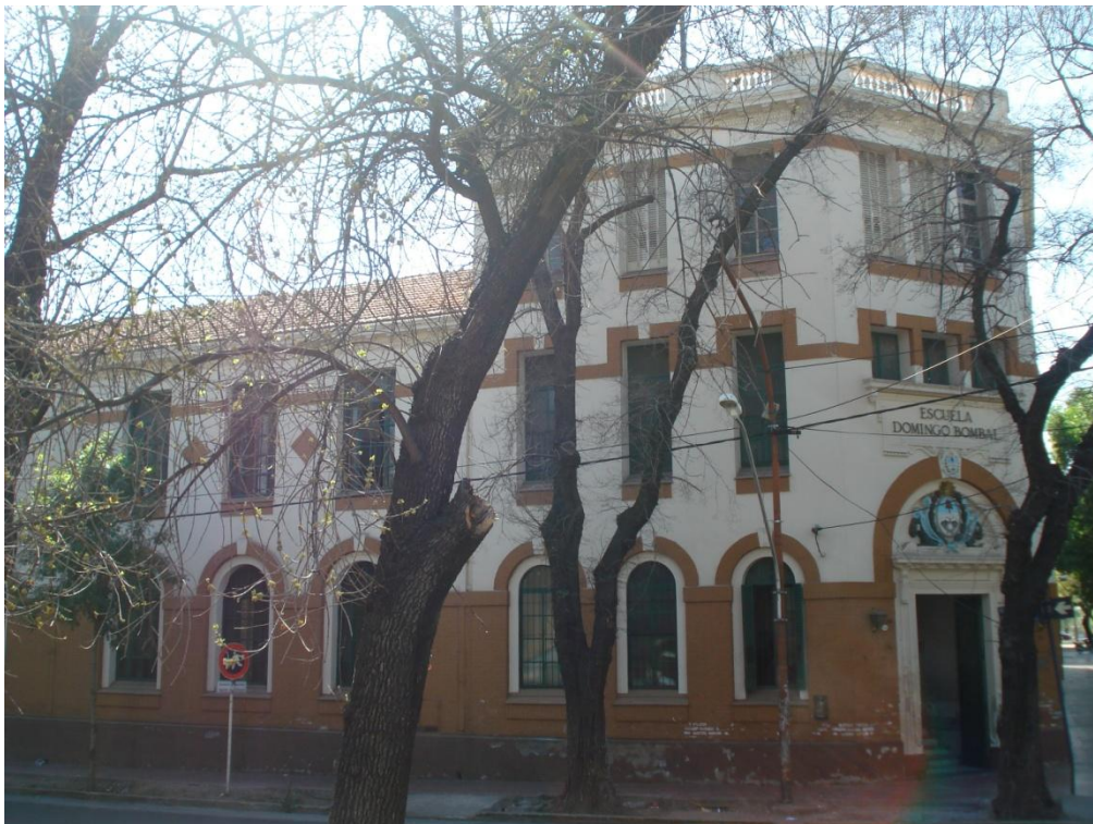
Escuela Domingo Bombal. Se encuentra ubicada en la esquina noreste de Lavalle y Montecaseros de Ciudad.
