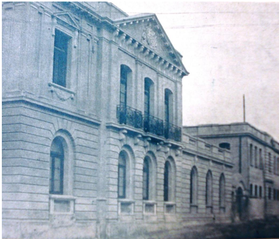
Frente lateral por calle Colón de la recientemente inaugurada Comisaría 7ª. Provincia de Mendoza. Dos años de ministerio. Gobierno del Dr. Alejandro Orfila. Memoria presentada por el Ministro de Industrias y Obras Públicas, Dr. José E. Aguilar a la Honorable Legislatura de Mendoza. Obras Públicas, 1926-1927. Colombatti & Cía. Ltda., Buenos Aires, 1928. Tomo 2.
