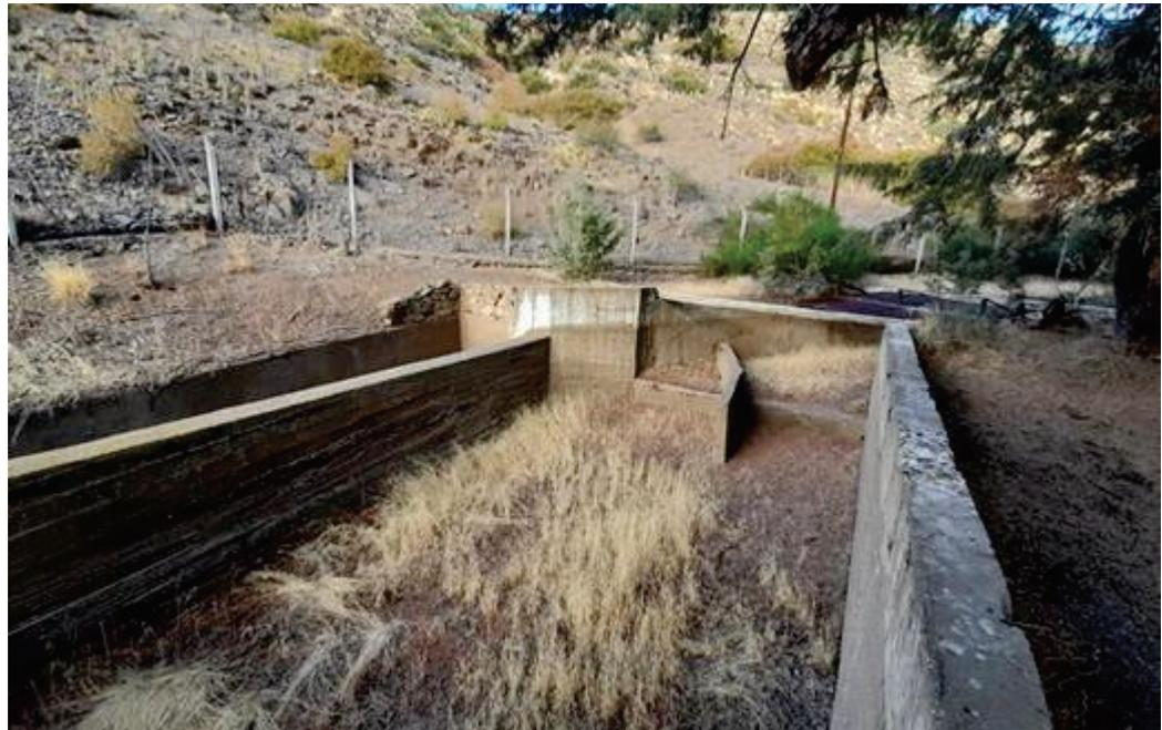
Figura Nº 3. Cámara de carga. Vista hacia aguas arriba.
