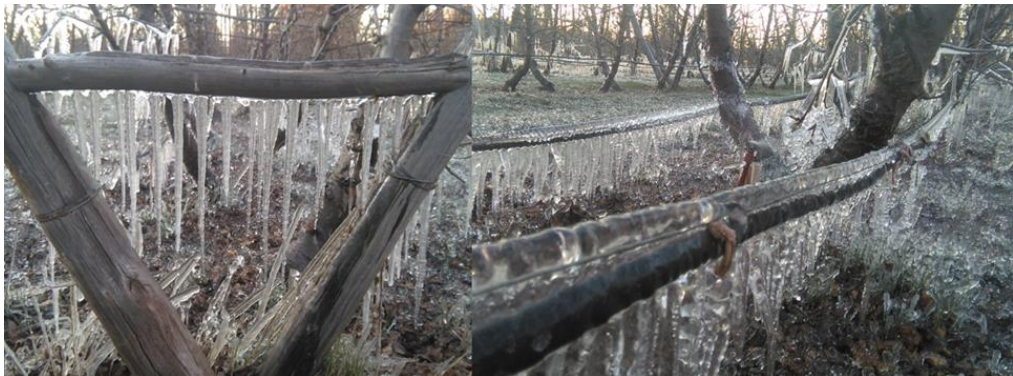
Figura 34: Izquierda: Estructura de soporte cubierta de hielo. Derecha: Mangueras de riego localizado cubiertas de hielo durante el control de heladas.
