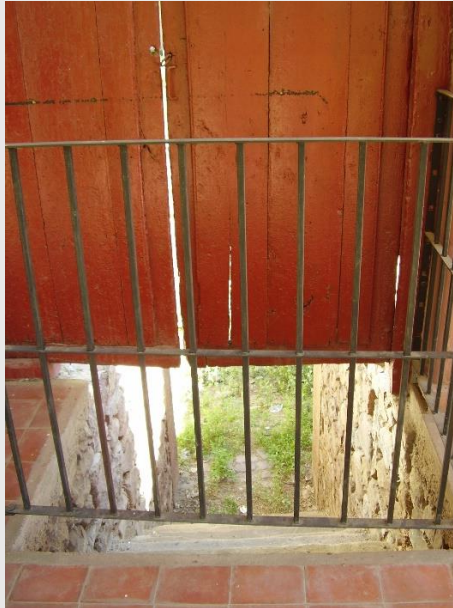
Entrada al túnel, hoy no habilitado
