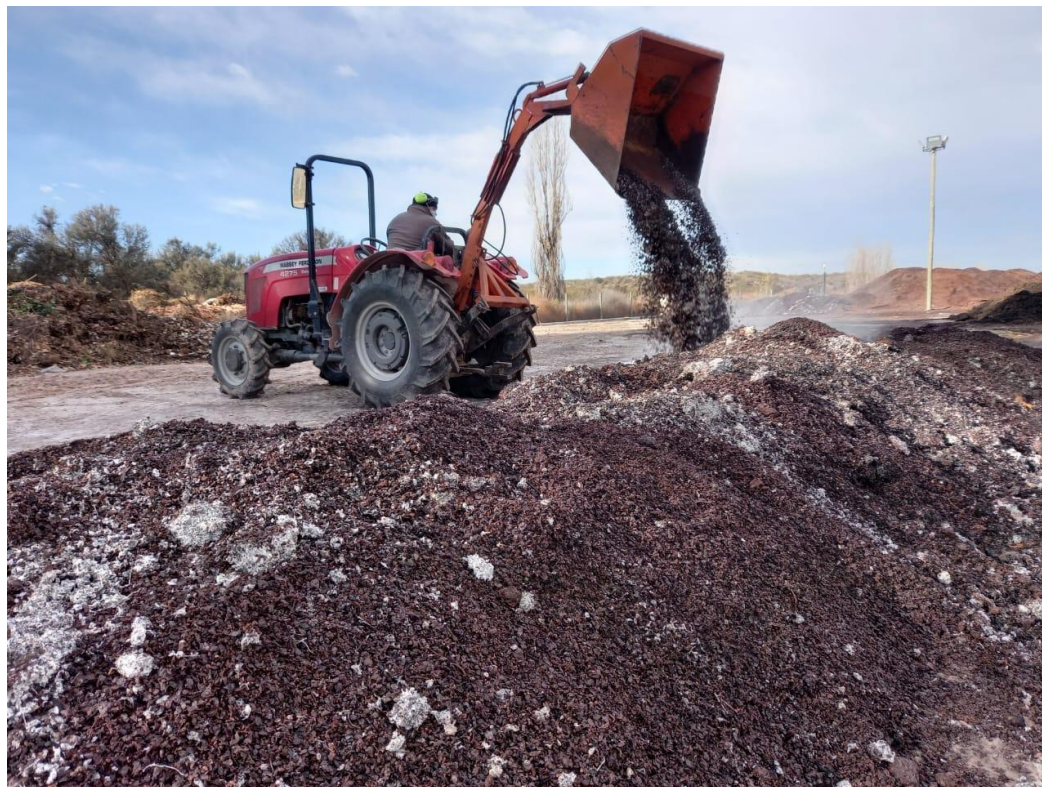
Figura 3 Armado de pila de prueba.
