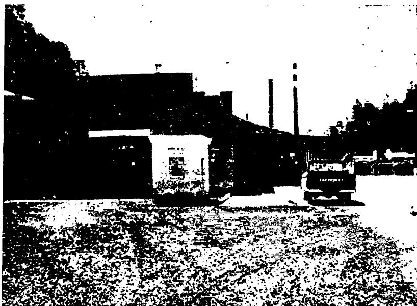
Fot. 13 -- Interior de la fábrica Bestani.
