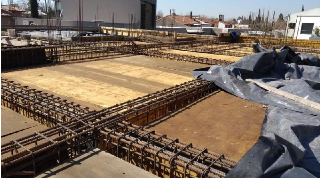
Figura 13. Vista encofrado losa y armadura superior vigas varias.
