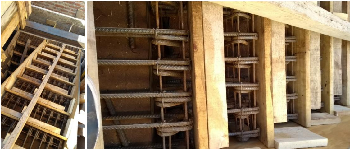
Figura 14. Armado escalera mediante estribos
